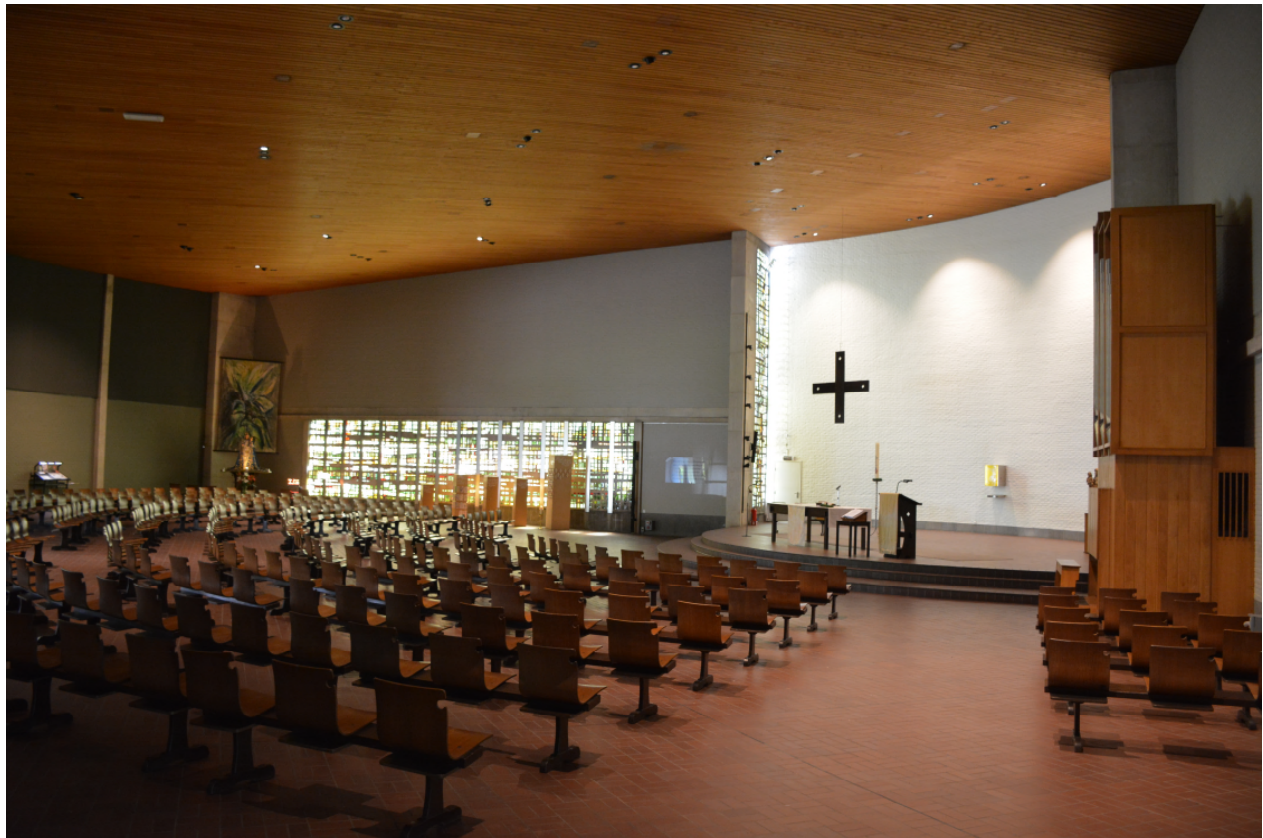
Zicht op de linkerhoek en achterwand De volledige achterwand is bovenaan bekleed met akoestische panelen waardoor de galmtijd werd gehalveerd.
